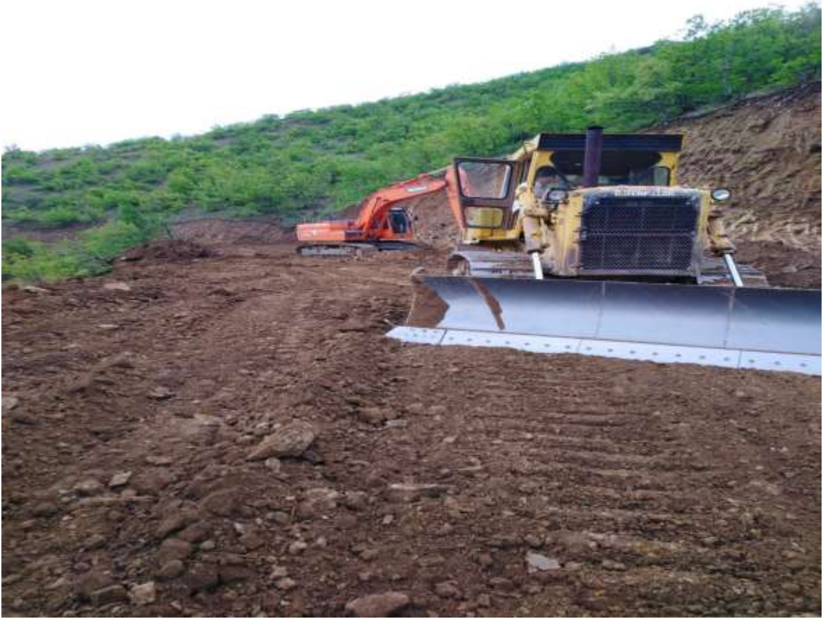
Şiran Pelitli Köyü Yol Onarım Çalışması
