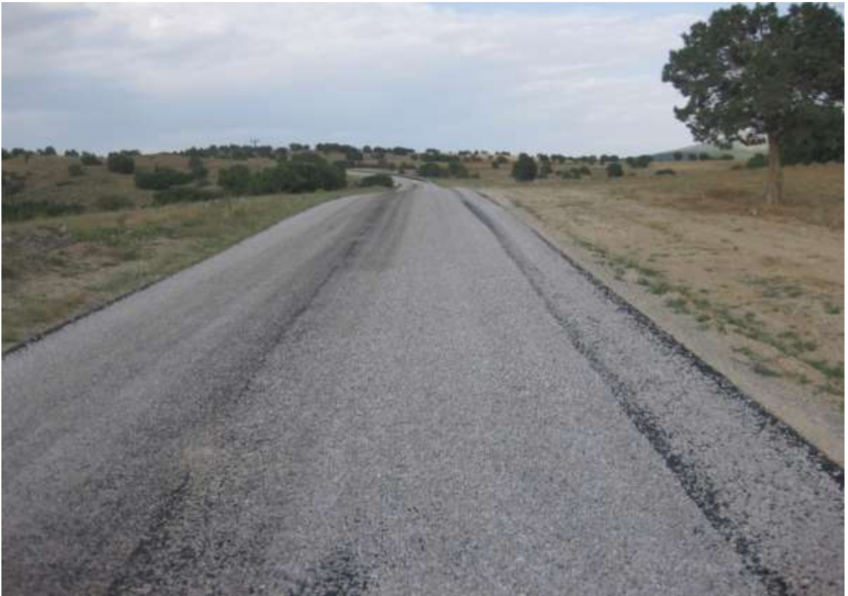
Şiran Günyüzü Asfalt Çalışması
