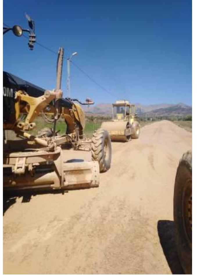
Şiran İnözü Köyü Stabilize Çalışması
