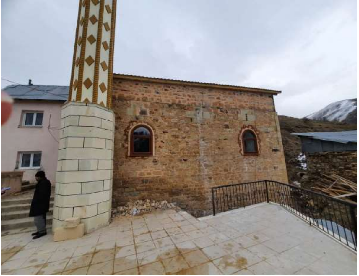
Merkez Tandırılık Köyü Camii Onarım İşi
