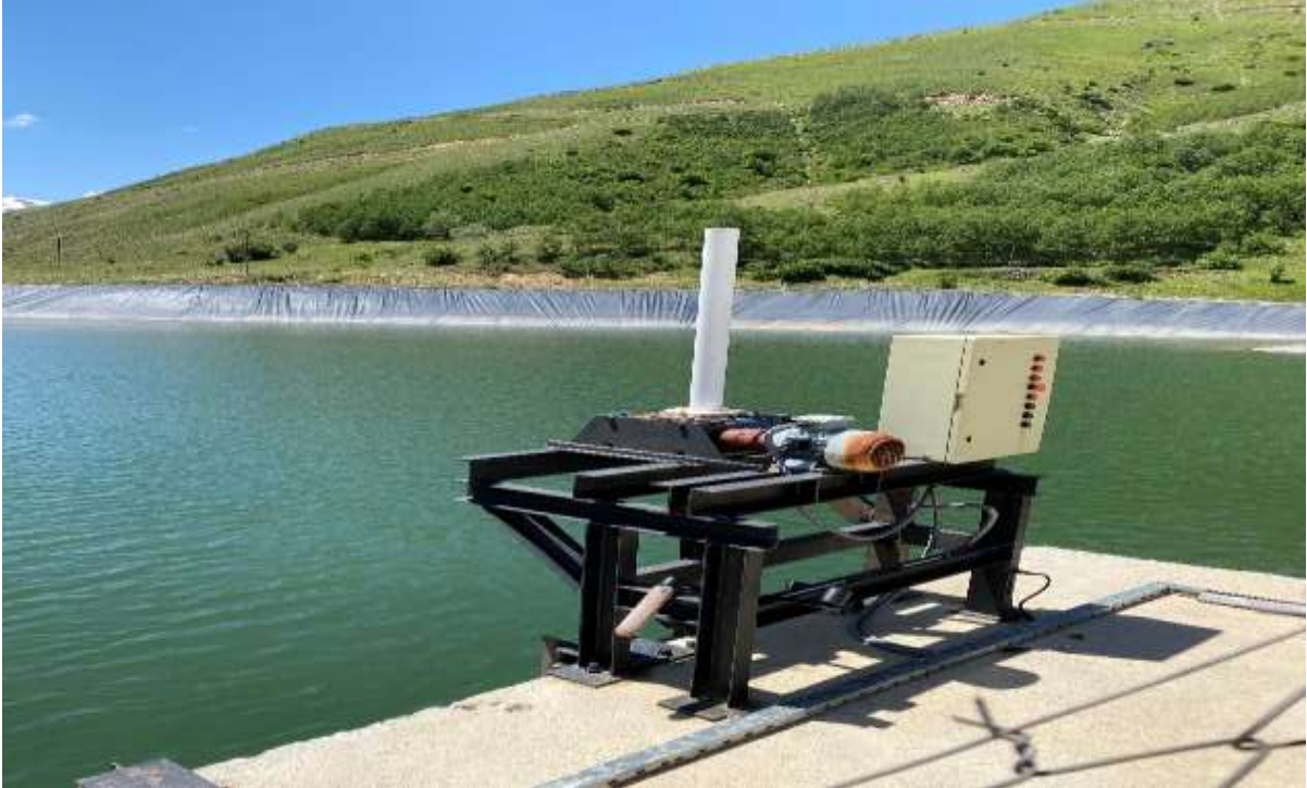
Torul-Güzeloluk Köyü-Hidroelektrik Santrali
