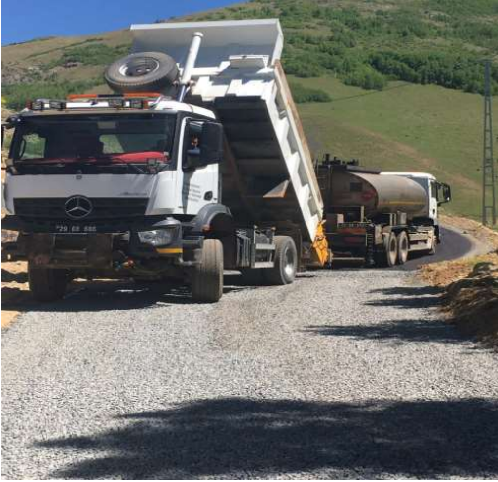
Sarıççek Köy Yolu Asfalt Çalışması
