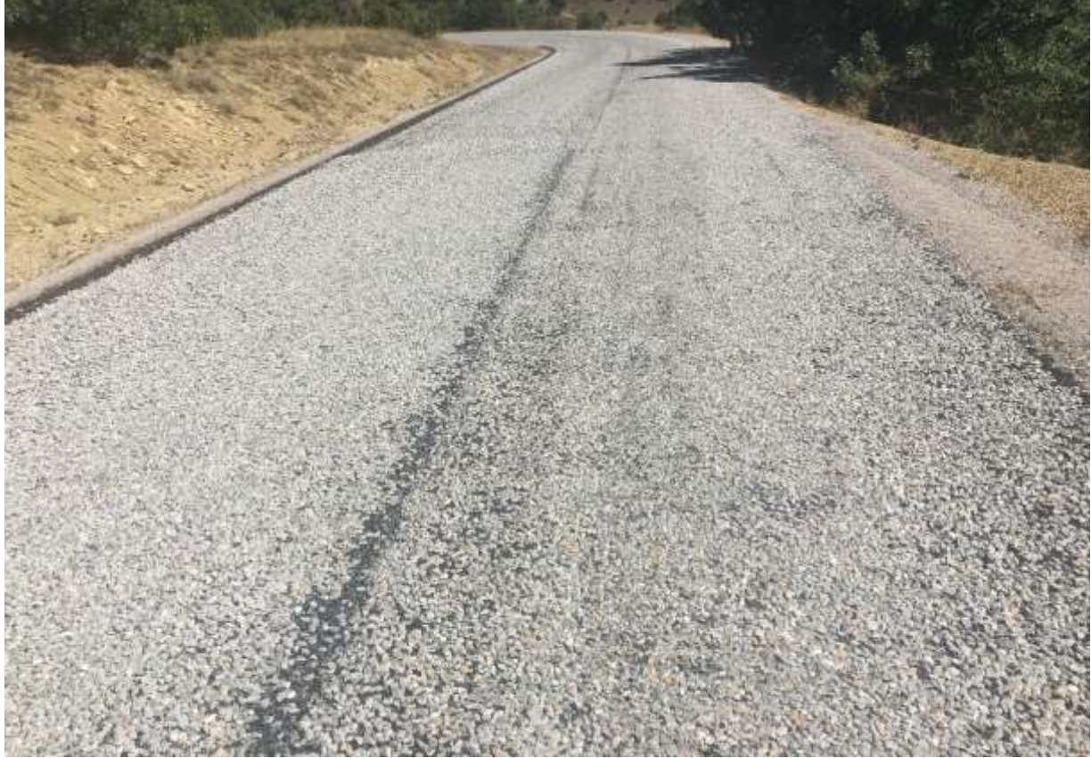
Merkez Akpınar Köyü Asfalt Çalışması
