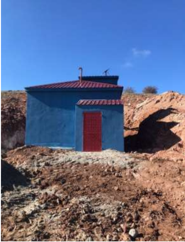
Köse Akbaba Köyü Depo Yapımı
