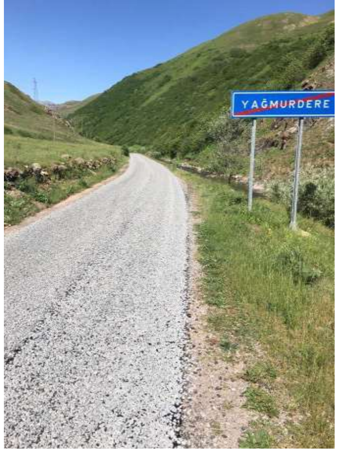
Merkez Yağmurdere-Beşoba Grup Yolu Asfalt Çalışması
