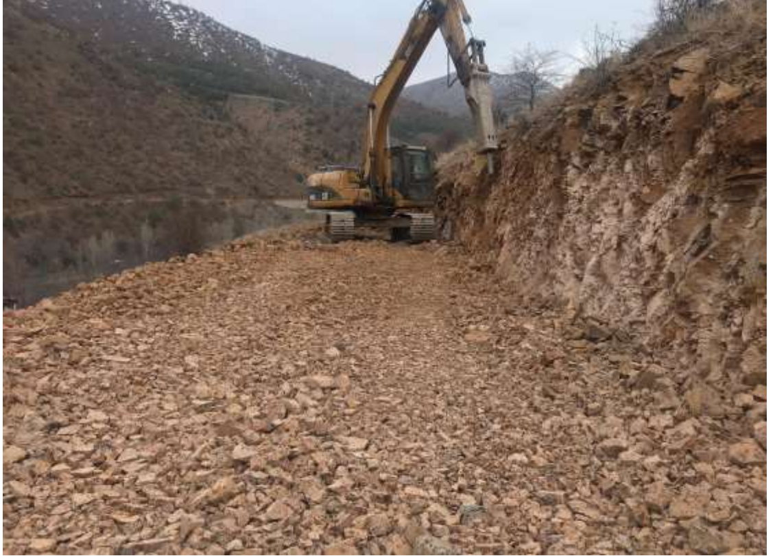
Tekke Mahalle Yolu Yol Geniřletme Yapım İři
