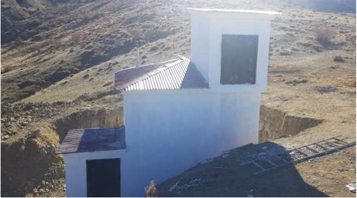
Kelkit Balkaya Köyü İçme Suyu Deposu
