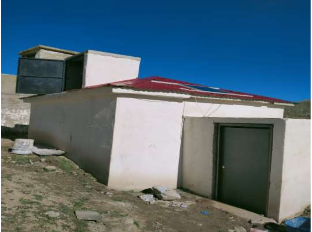
Köydes İmesuyu alıřmaları (Beřoba köyü)
