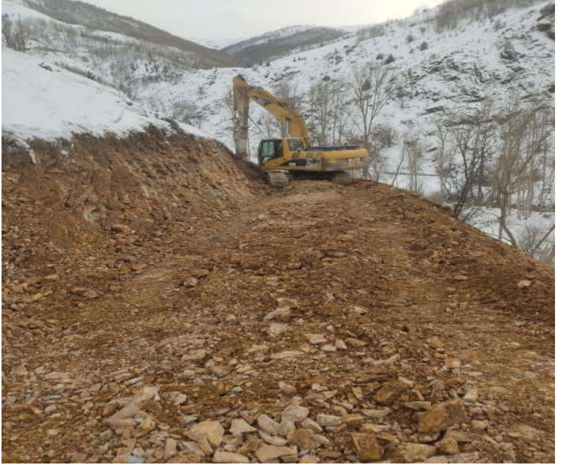
Merkez Olucak Köyü Arazi Yolu Yapım İşi
