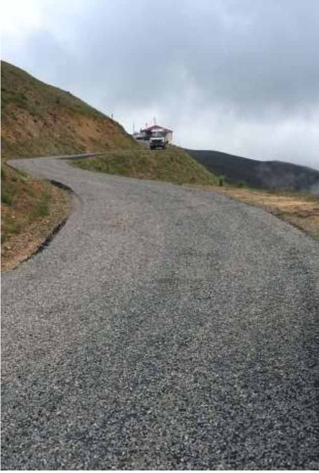
Merkez Çorak Köyü Asfalt Çalışması
