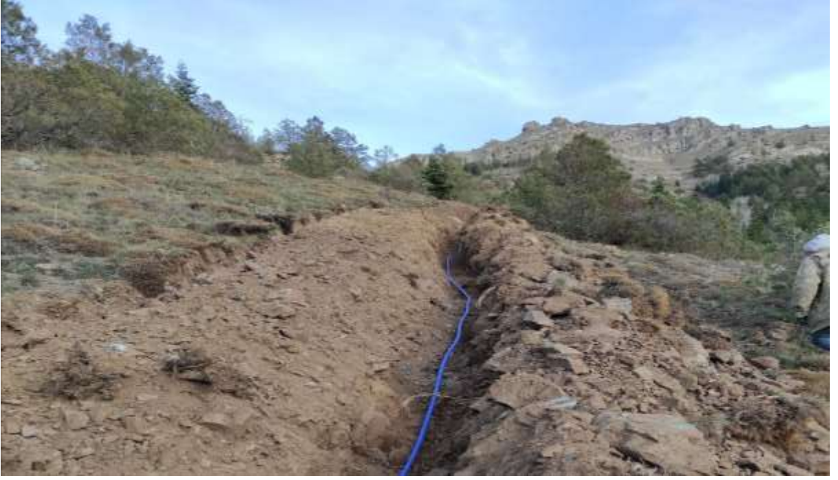
Merkez Üçkol Köyü İsale Hattı Yapımı
