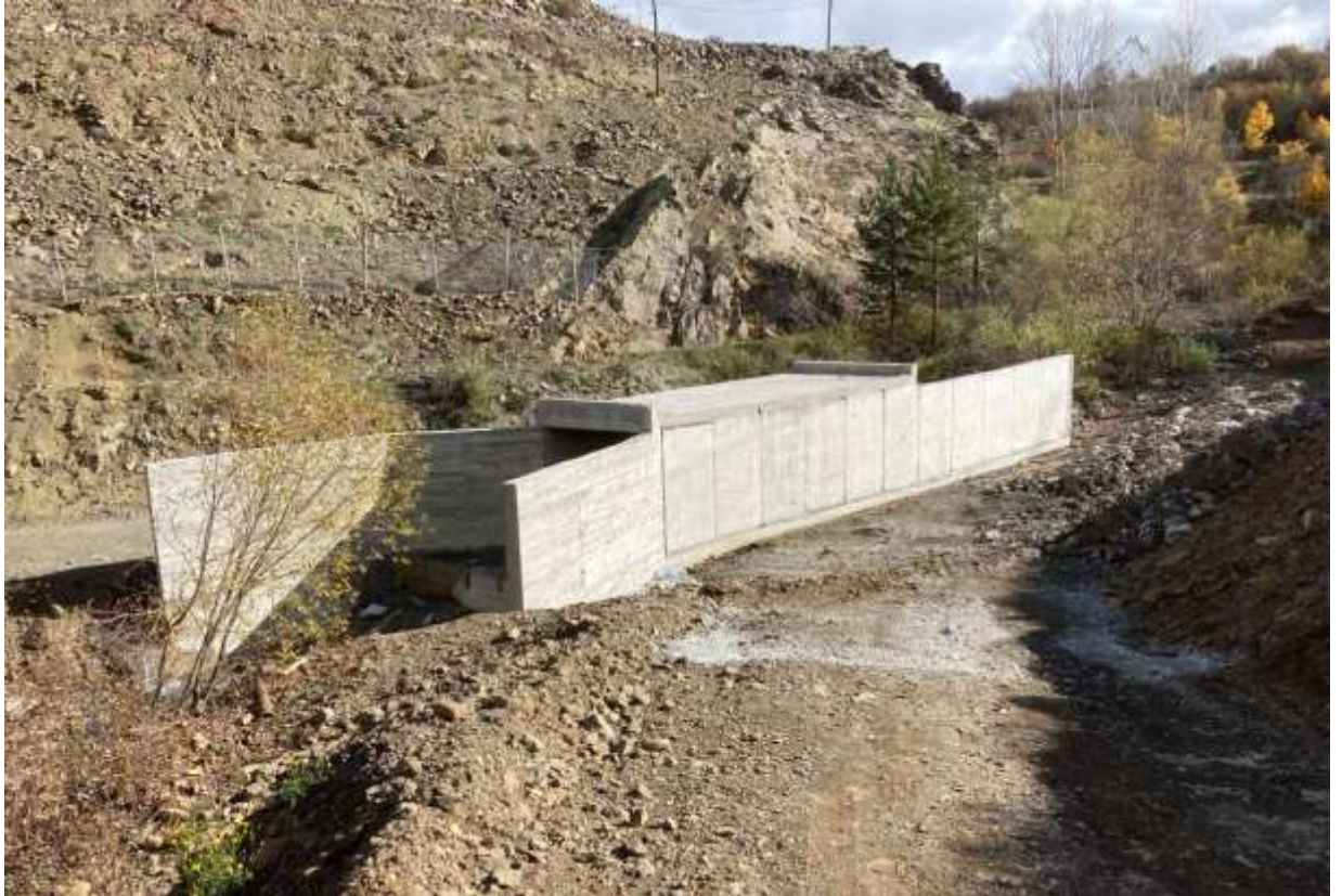
Merkez Sungurbeyli Köyü Menfez Yapım İşi
