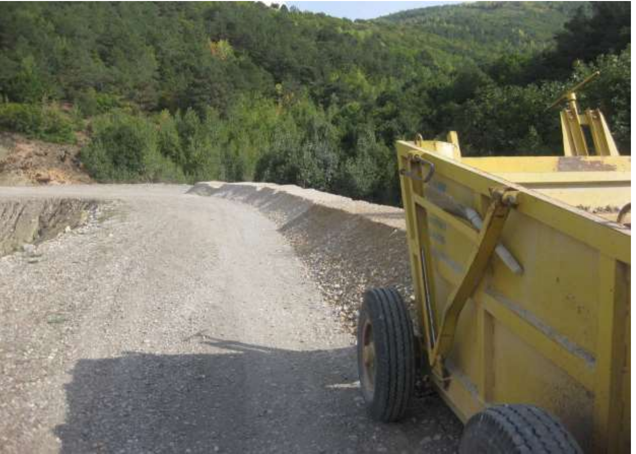
Kelkit Çamur Köyü Asfalt Alt Temel Çalışması
