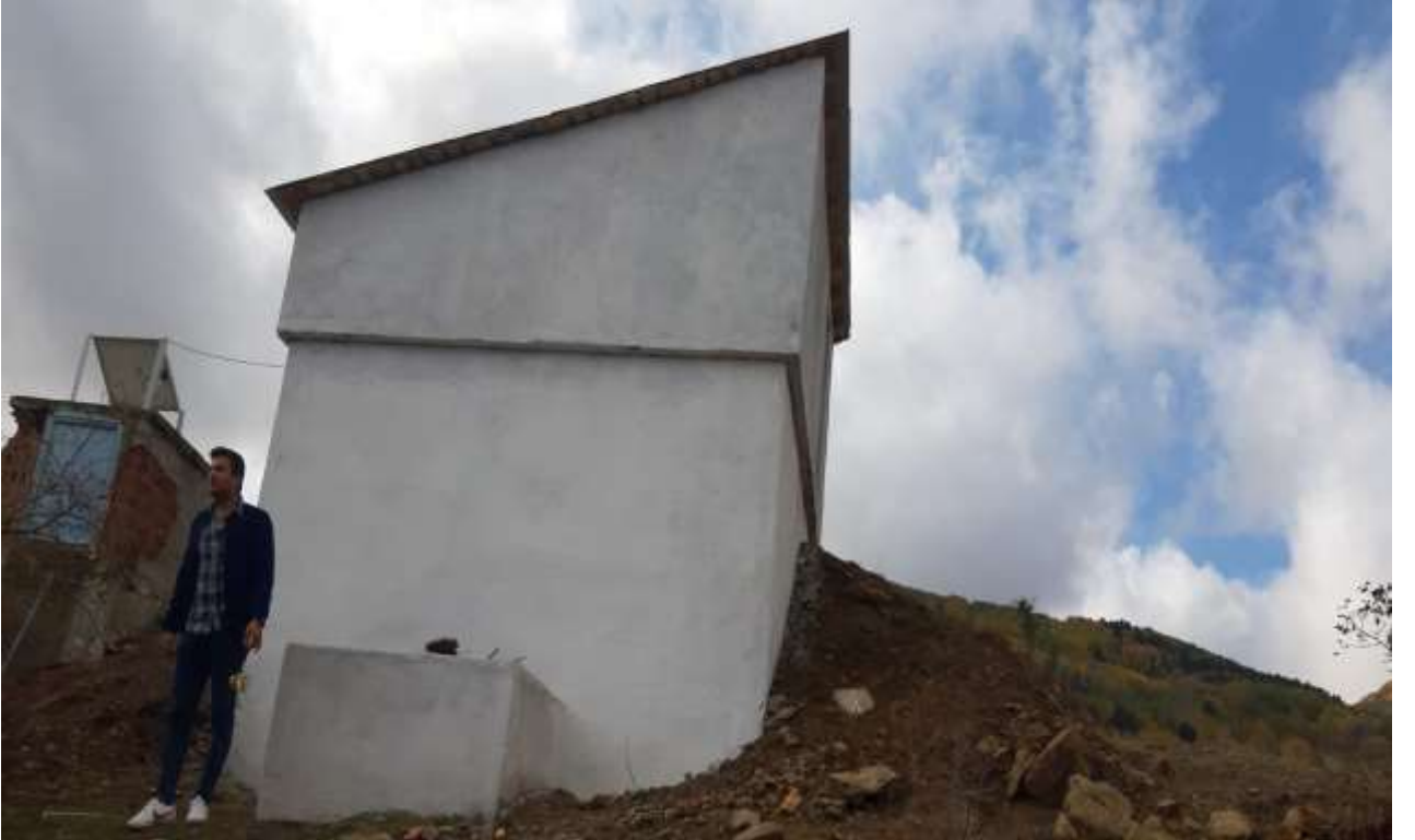
Merkez Çalık Köyü Depo Onarımı
