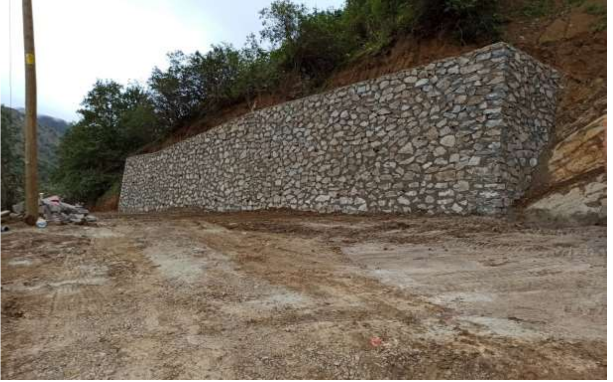
Torul İlecik Köyü Taş Duvar Yapım İşi
