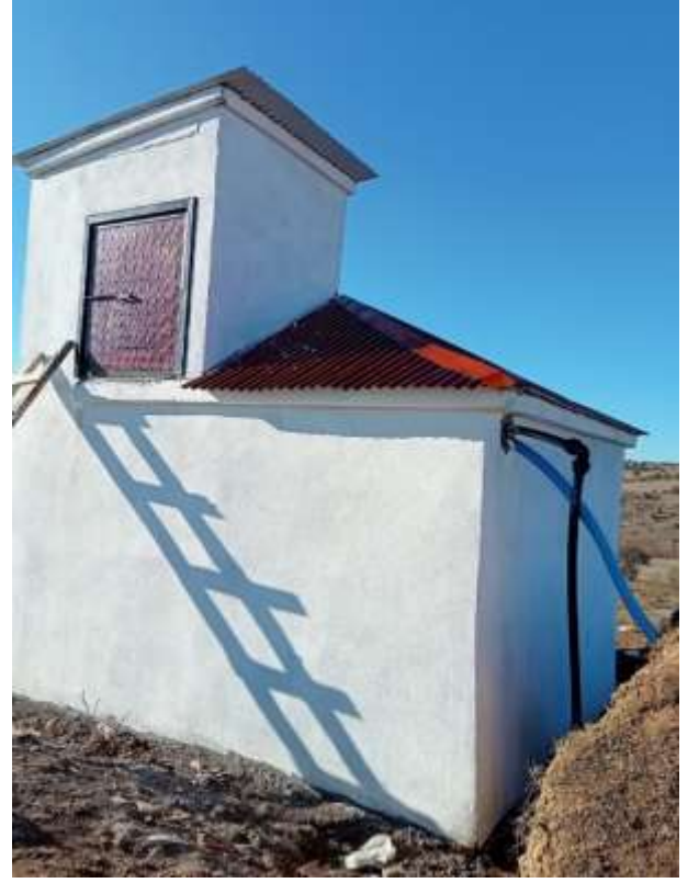
Şiran Babuş Köyü Depo Yapımı
