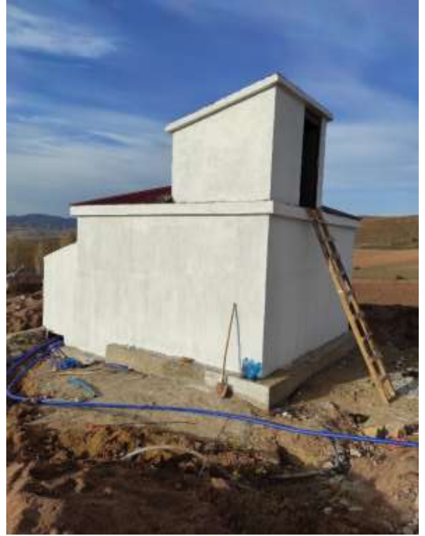
Köse Övünce Köyü Depo İnşaatı
