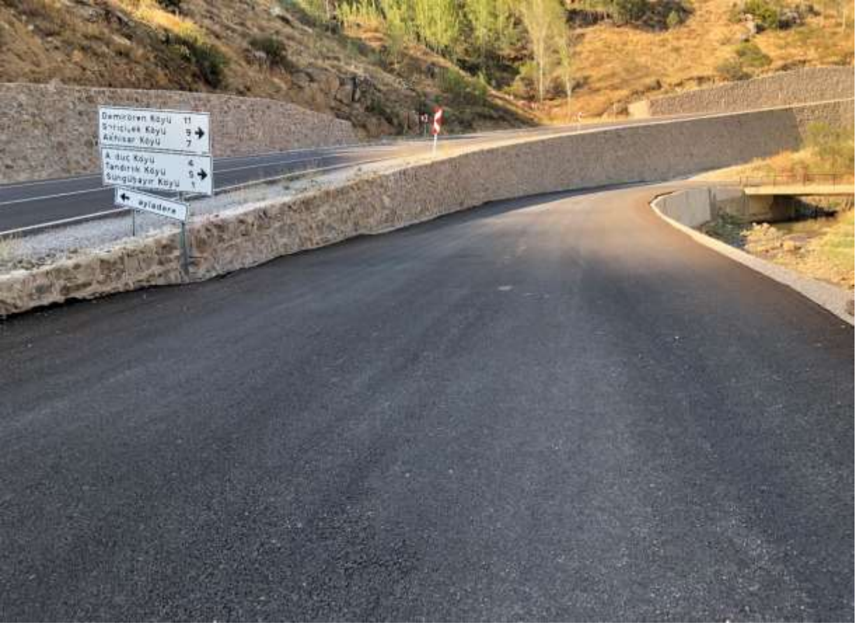
Sarıççek Grup Yolu BSK asfalt
