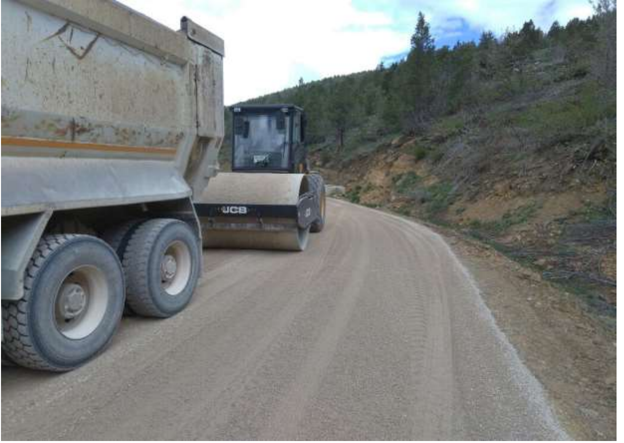
Şiran Yeniköy Stabilize Çalışması
