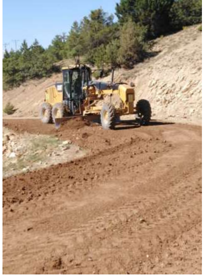
Şiran Tepedam-Aş.Duruçay Bağ. Yolu Malzemeli Bakım
