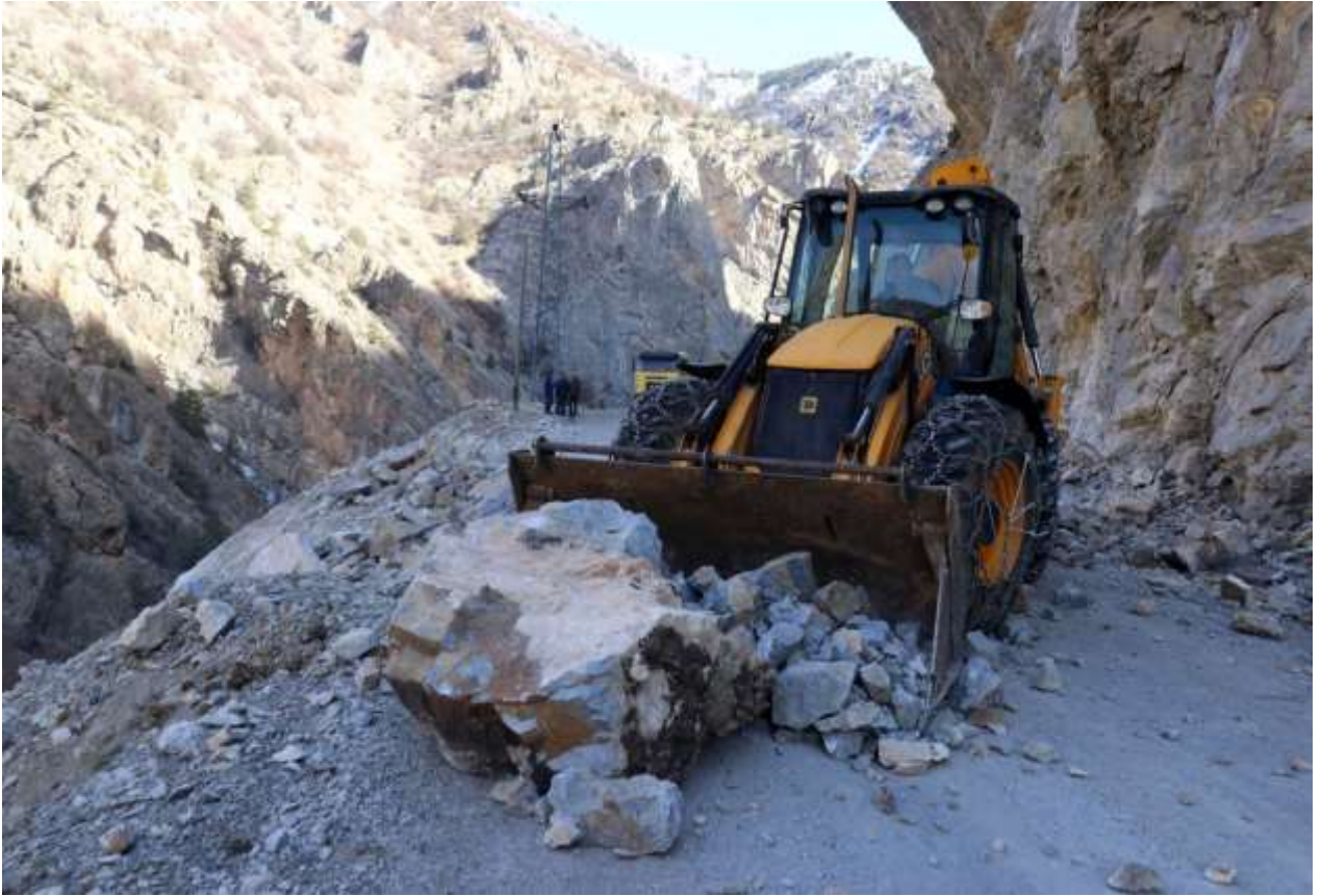
Merkez Yağlıdere Köyü Yolu Şev Temizliği (Kaya Düşmesi)
