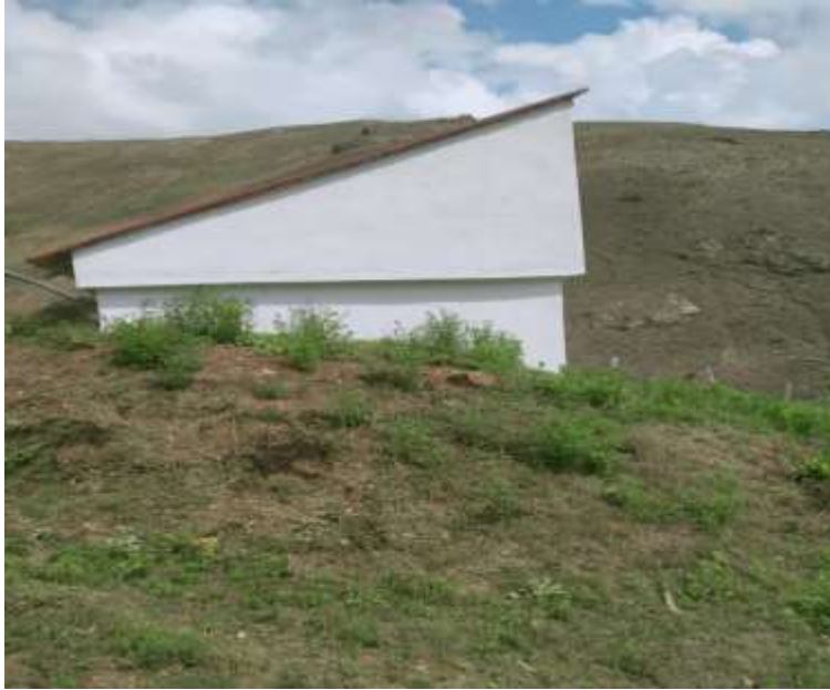
İkiz Köyü İçme Suyu Deposu İnşaatı
