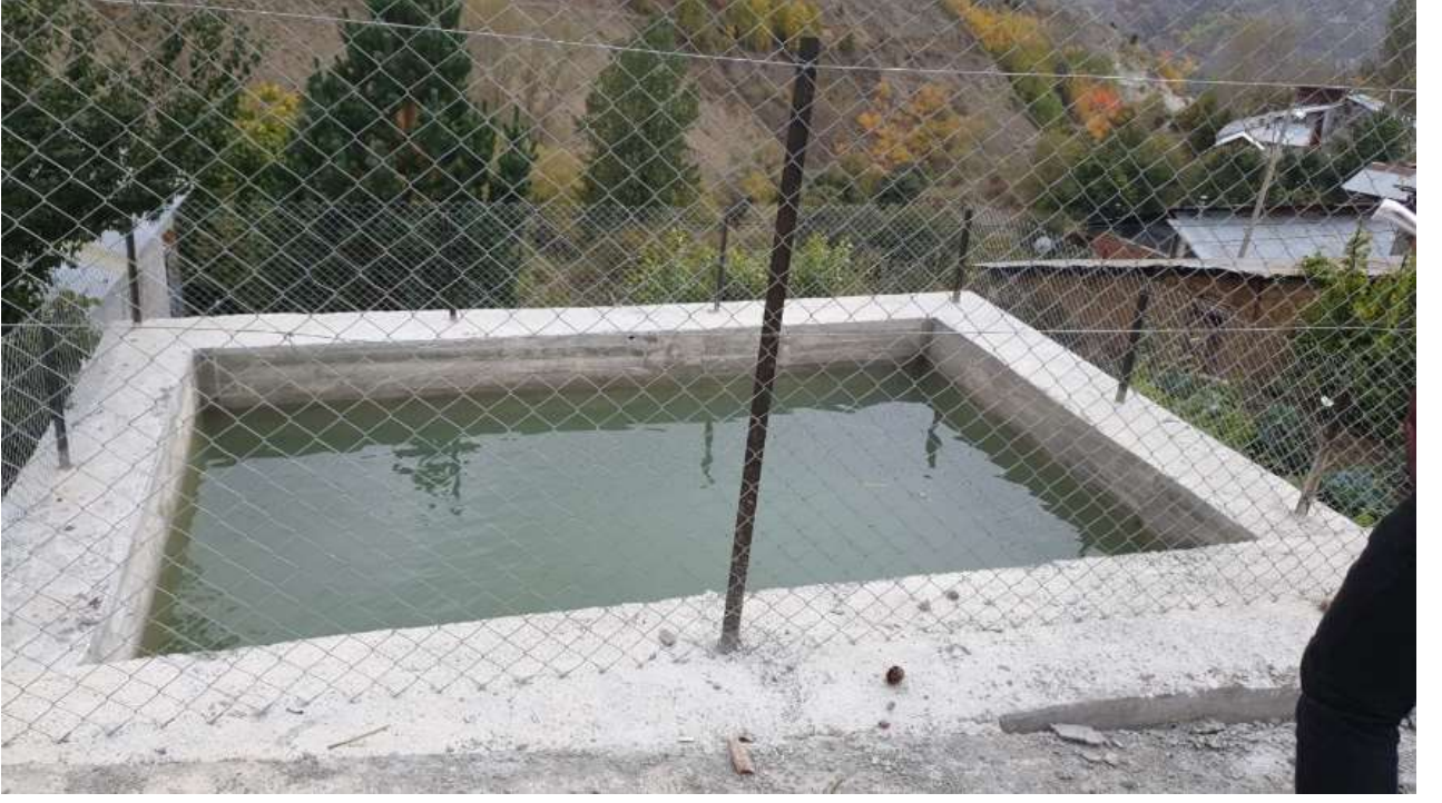
Merkez Aktutan Köyü Sulama Havuzu Onarımı
