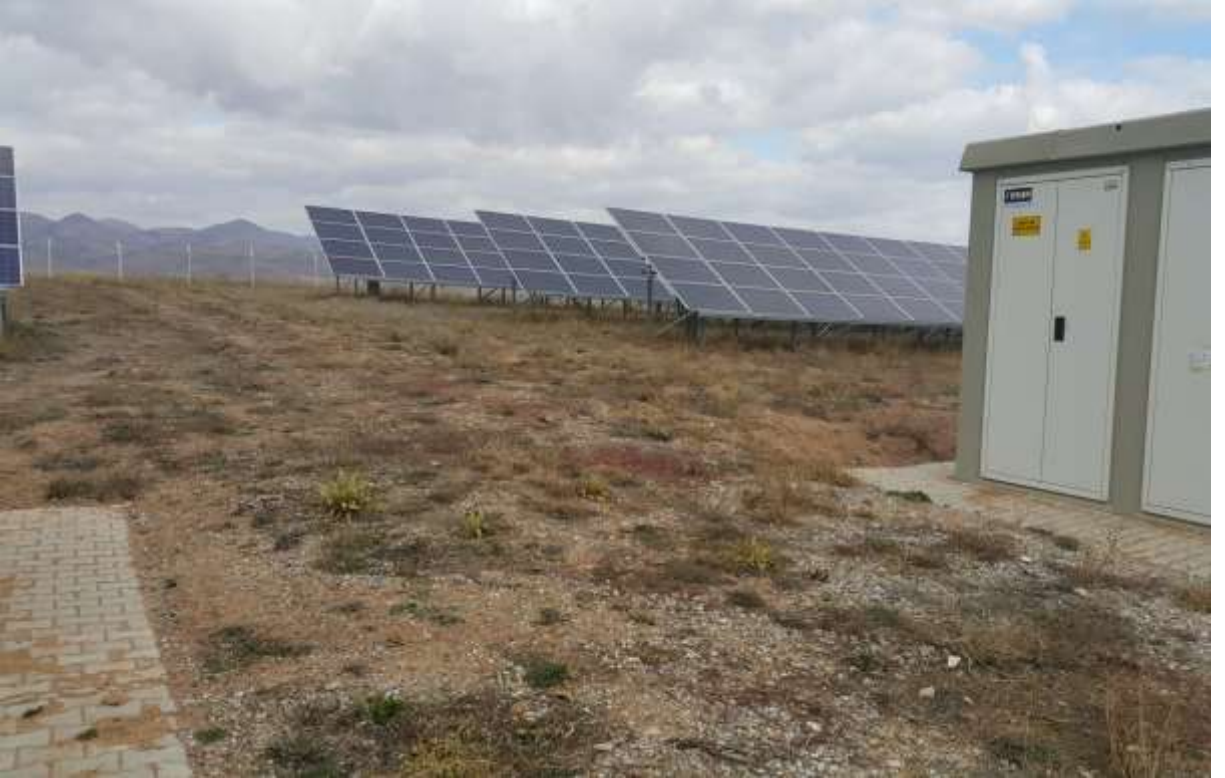
Köse -Gökçeköy (Güneş Enerji Santrali) Kale GES Üretim Ltd. Şti.
