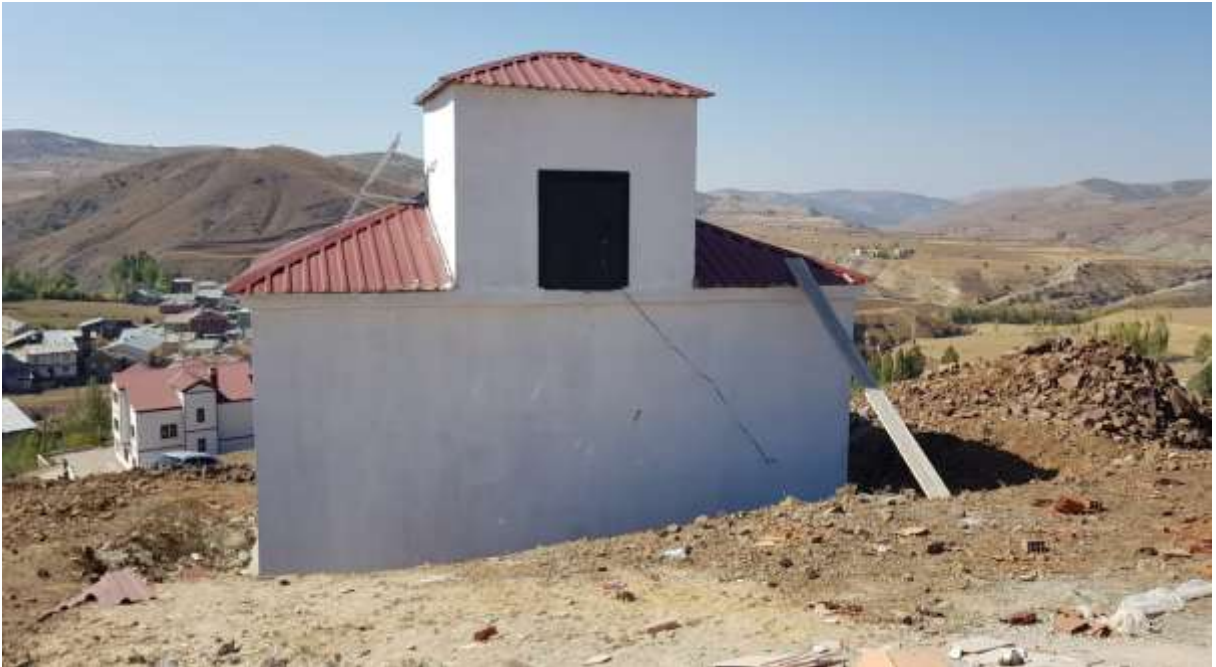
Kelkit Çamur Köyü İçme Suyu Deposu
