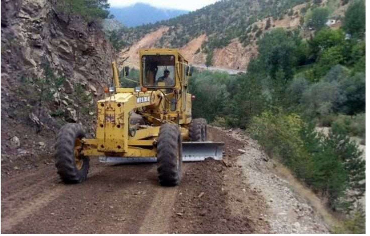
Karamustafa Köyü Mahalle Yolu Malzemeli Bakım Çalışması
