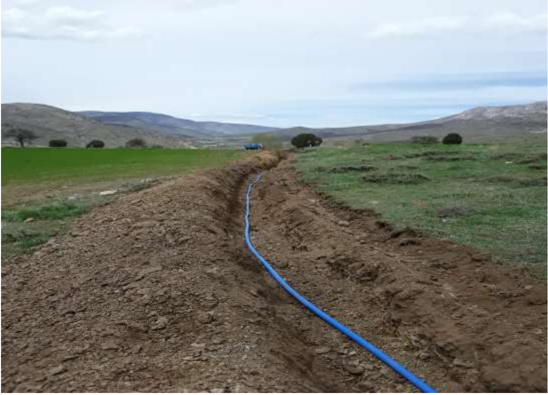
Kelkit Aşağı Özlüce Köyü Devlet Köylü İşbirliği İçmesuyu İnşaatı
