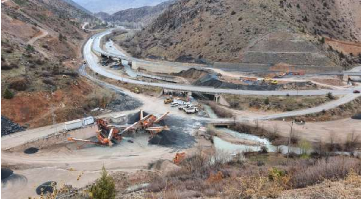
Merkez -Kale Köyü (Kırma Eleme Tesisi) İl Özel İdaresi
