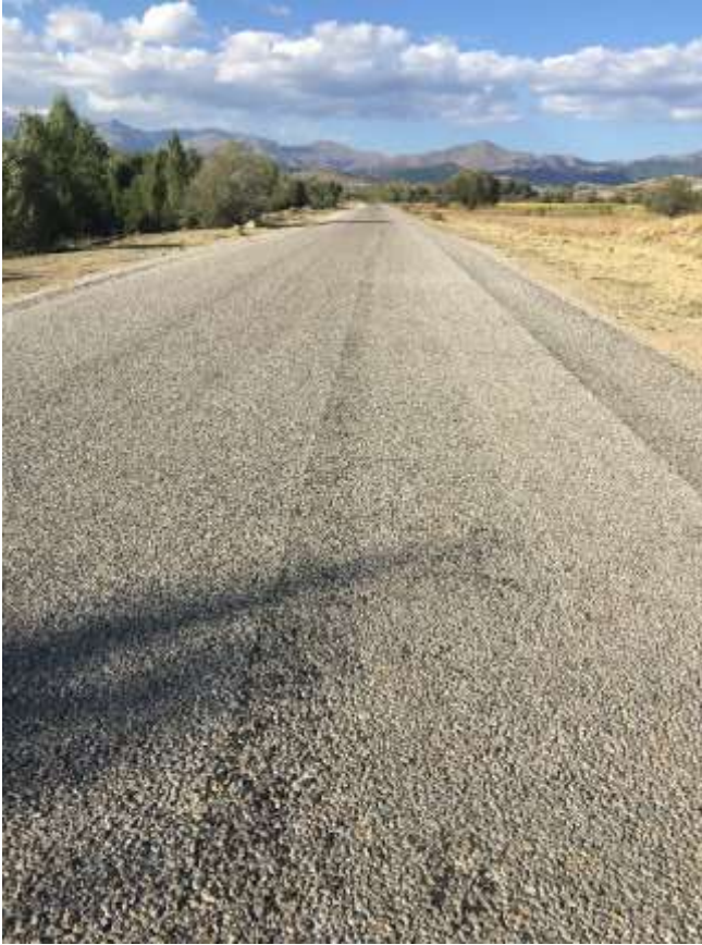
Şiran Kozagaç Grup Yolu Asfalt Çalışması
