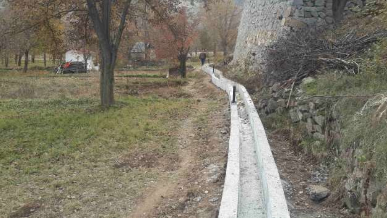
Merkez Yeni yol Köyü Sulama Tesisi
