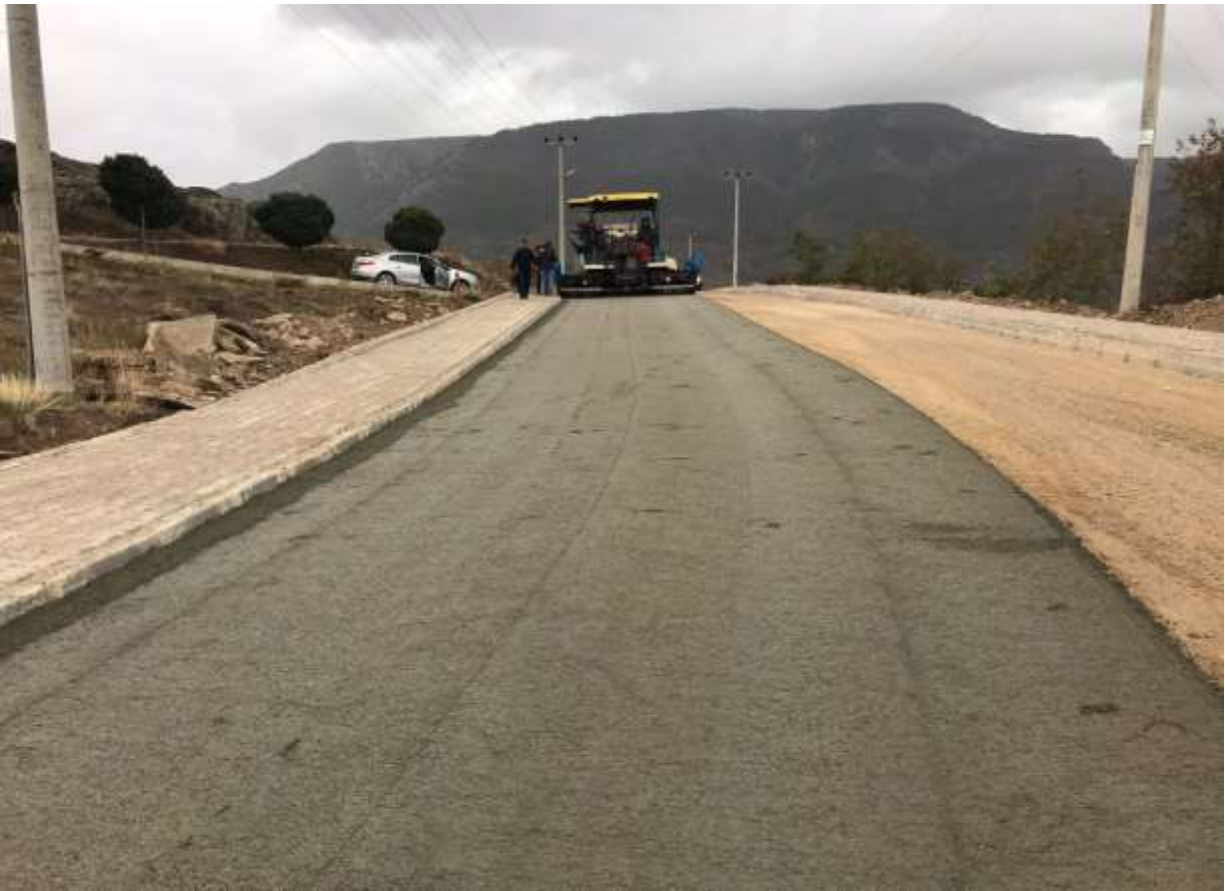
Gümüşhane Organize Sanayi Bölgesi Silindirle Sıkıştırılmış Beton Yol
