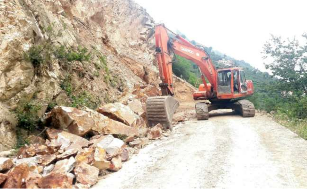
Kürtün Üçtaş Köyü Yolu Heyelan Kaldırma Çalışmaları
