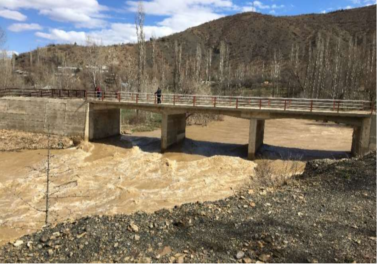
Şiran Seydibaba Bağ Mahallesi Köprü Çalışması
