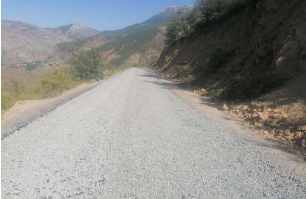
Torul Bahçelik Köyü Asfalt Çalışması
