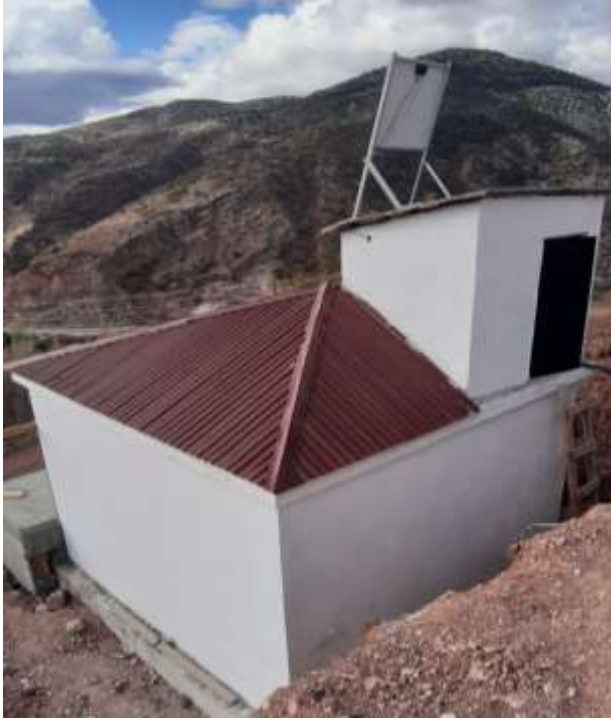
Merkez Çayırardı Köyü Depo Onarımı
