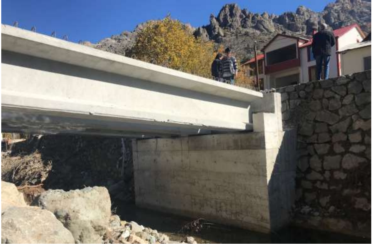
Merkez Dibekli Köyü Köprü İnşaatı
