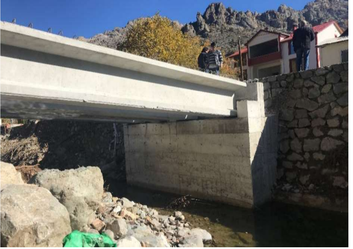
Merkez Dibekli Köyü Köprü Çalışması
